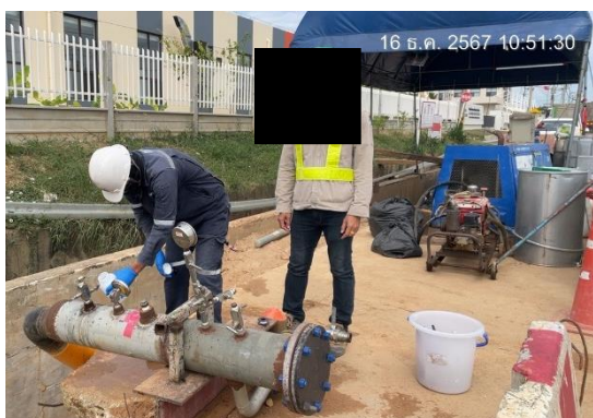
รูปที่ 3-10 การติดตามตรวจสอบคุณภาพน้ำทั้งจากการทดสอบการรั่วไหลของท่อด้วยวิธีชลสถิต (Hydrostatic Test) ของโครงการฯ ในระยะก่อสร้าง
