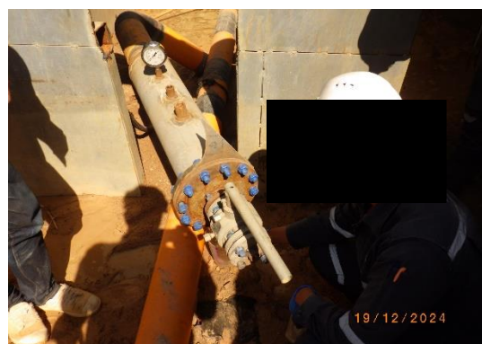
รูปที่ 3-10 การติดตามตรวจสอบคุณภาพน้ำทั้งจากการทดสอบการรั่วไหลของท่อด้วยวิธีชลสถิต (Hydrostatic Test) ของโครงการฯ ในระยะก่อสร้าง
